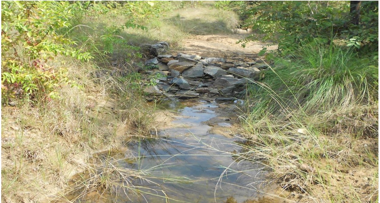
LOOSE BOULDER CHECK DAM--Karmeli mini Watershed , Saintala block, Odisha
